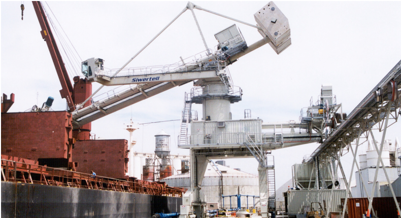
SIWERTELL TERMINAL - USA
